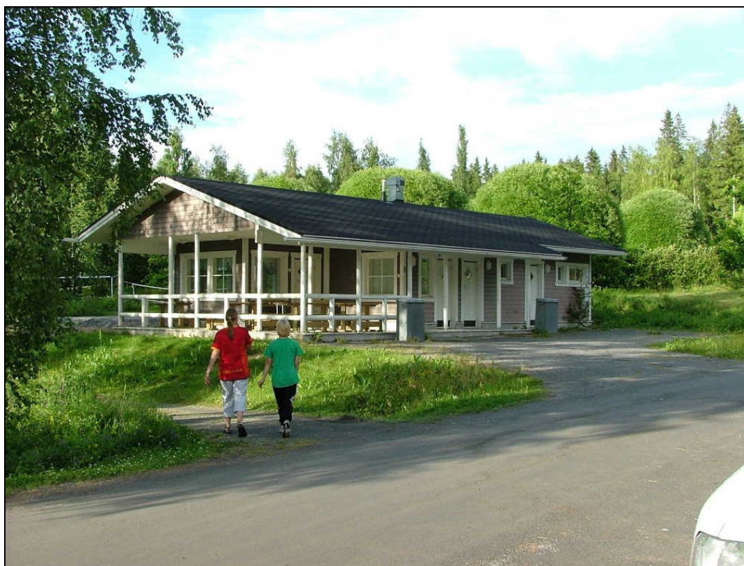
Kuva 5. Leirintäalueen uusi huoltorakennus (kuva Petri Hirvimäki).
