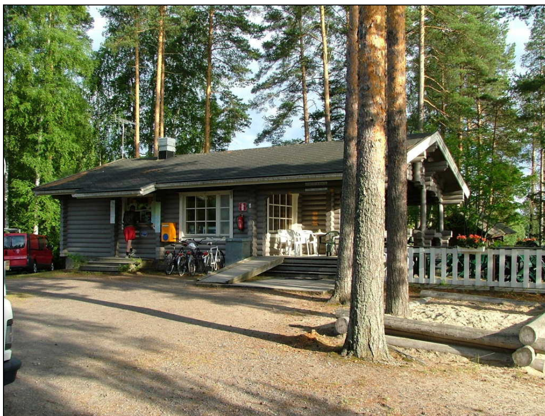
Kuva 3. Vastaanottorakennus (kuva Petri Hirvimäki).
