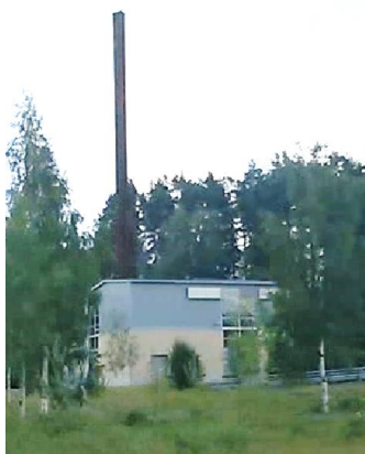
Kuva 9: Lämpölaitos valtatieltä päin
