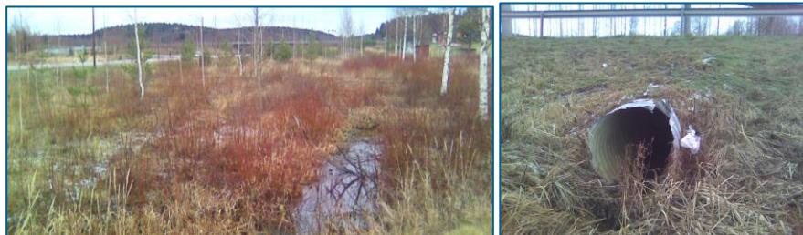
Kuva 35: Valtatien itäpuolella oleva, 30 – 50 m leveä painanne ja valtatie alittava putki.
