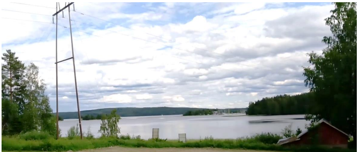
Kuva 4: Eteläosan ylittää 110 kV:n sähkölinja.
