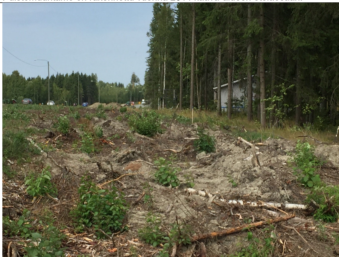
Näkymä muuntamon suunnasta pohjoiseen.
