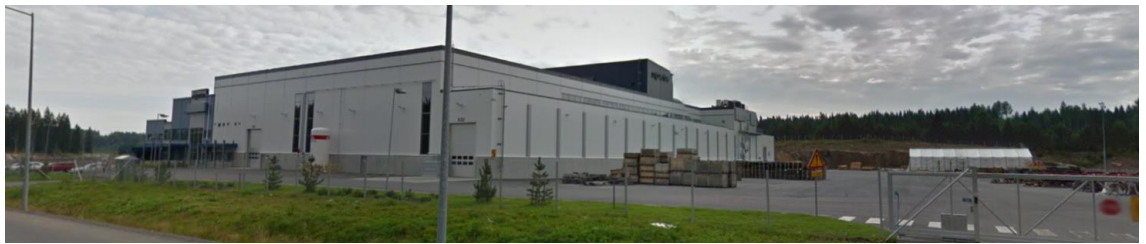
Kuva 9: Koillisessa, Jyväskylän puolella, sijaitseva teollisuusrakennus.
