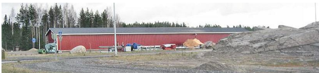
Kuva 11: Härköojantien (nyk. Eteläportintie) alkupäässä oleva varastorakennus.
