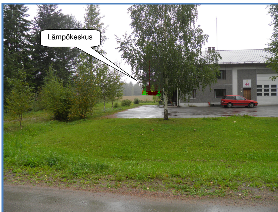
Kuva 1. Lämpökeskus nähtynä Länkipohjan paloaseman nurkalta.
