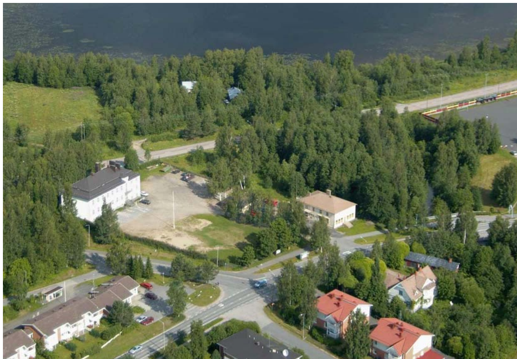
Kuva 1. Vanha koulu sijaitsee keskeisellä paikalla Muuramentien varrella.
