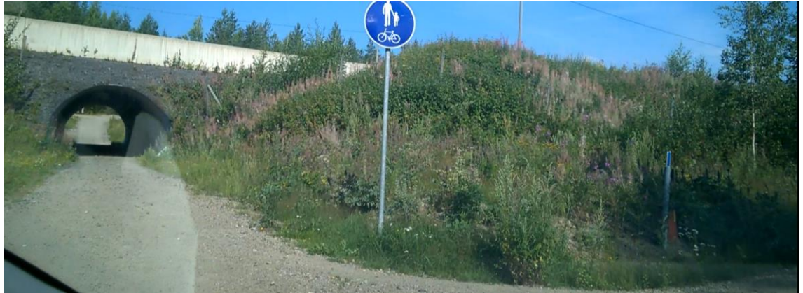
Kuva 9: Eteläinen alikulku ja valtatie sekä asuinalueen välinen pengerrus, joka suojaa aluetta melulta.
