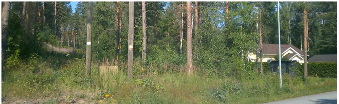
Kuva 11: Kuvassa oikealla Havutien varrella sijaitseva uudehko muuntamo.
