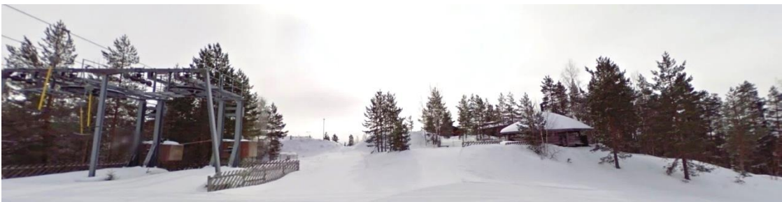
Kuva 4: Näkymä tontille rinteiden suunnasta pohjoisesta
