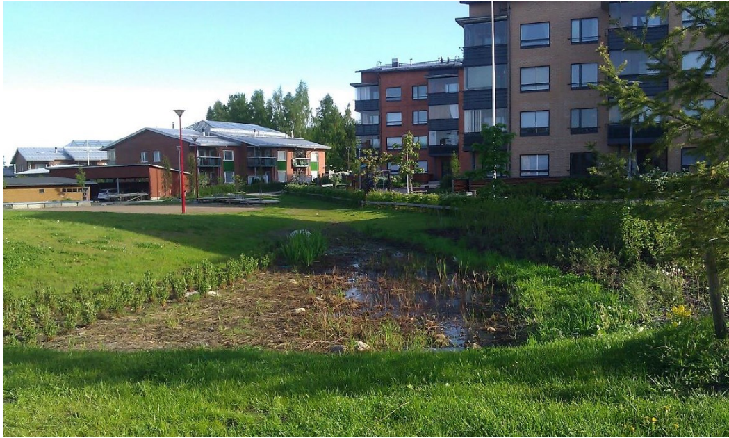
Hulevesisuunnitelman kuva 6: Viivytyspainanne Tampereen Muotialassa (FCG).
