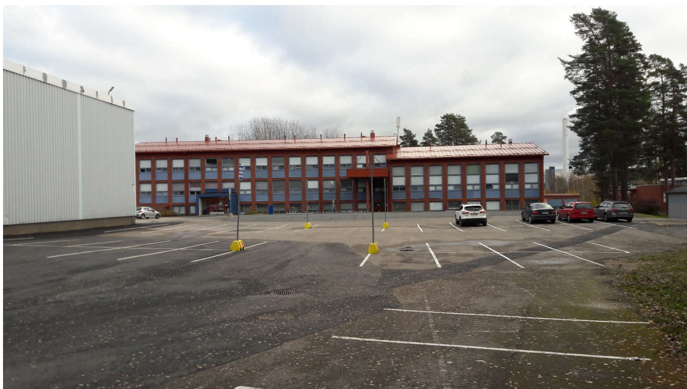
Liite 6. Valokuva koulurakennuksen pihanpuoleisesta julkisivusta sekä parkkikentästä. Parkkialueen takana olevalla sorakentällä sijaitsee ruokalarakennus. Vasemalla näkyvissä liikuntahalli.
