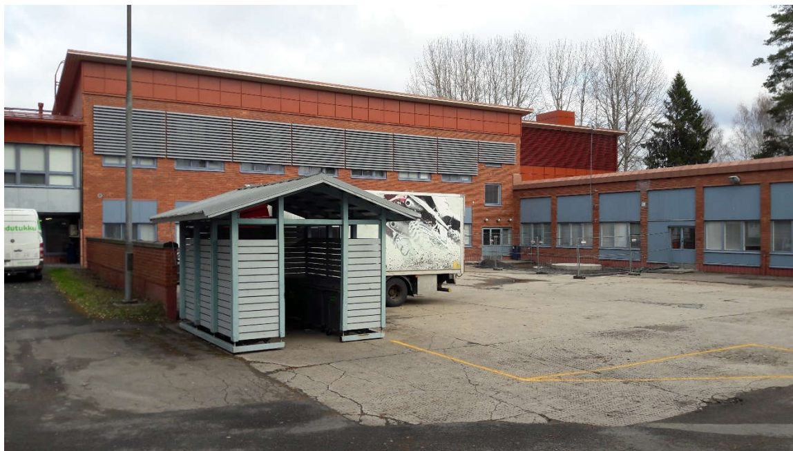
Kuva 30. Valokuva koulurakennuksesta sisäpihalta päin kuvattuna.
