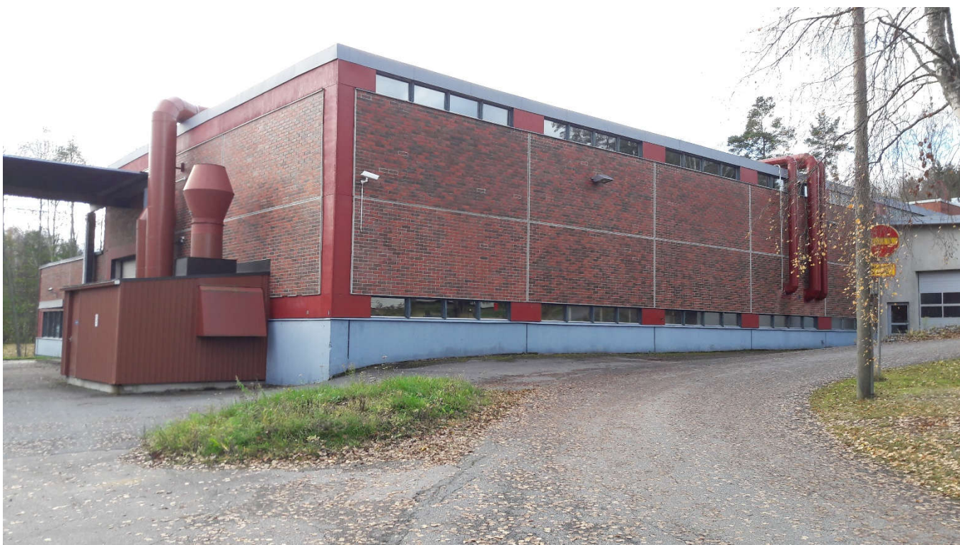
Liite 8. Valokuvassa "metallitalo" joka on osa verstaasrakennusta. Kuvan oikeassa reunassa näkyvissä komposiitti laajennuksen betoniseinä.
