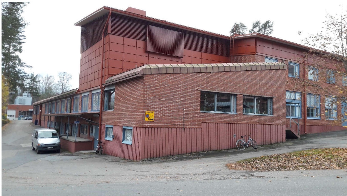
Liite 1. Valokuva koulurakennuksen työpajasiivestä Koulutien suunnasta.
