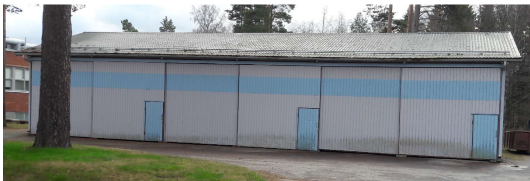
Kuva 25. Valokuva vuonna 1996 valmistuneesta ulkovarastosta. Tämä varasto korvasi aiemmin paikalla sijainneen varaston.
