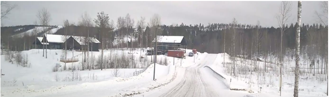
Kuva 15: Olevaa rakennuskantaa 26.2.2018. Salavantien varrelle valmistumassa oleva rakennus. Taustalla laskettelurinteitä. Edessä Salavantien alittava kevyen liikenteen tunneli.
