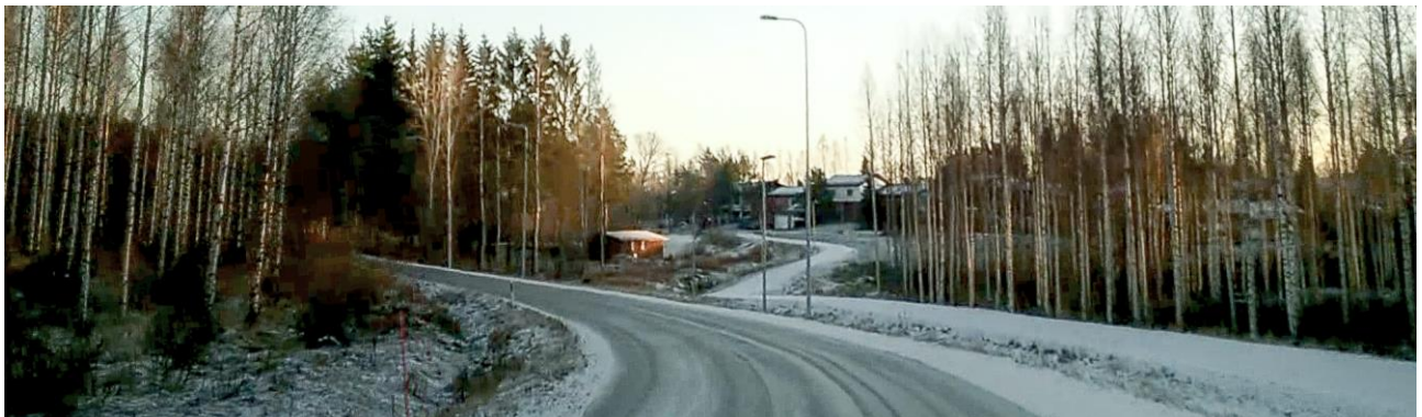
Kuva 37: Näkymä Pyyppöläntietä pohjoisesta päin tultaessa. Paloasema sijoittuu mutkan jälkeen vasemmalle.
