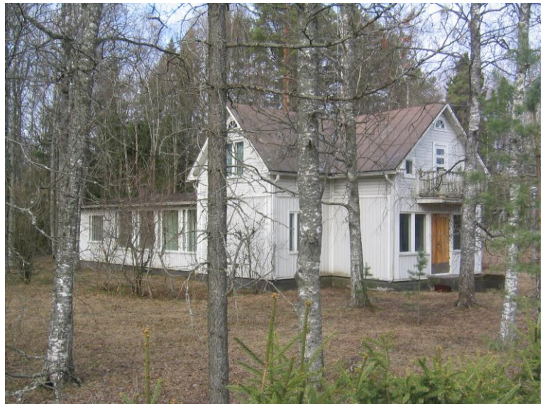
Kuva 8. Koivikon kiinteistö Koulukadun ja Valtakadun liittymästä nähtynä (kevät 2011)
