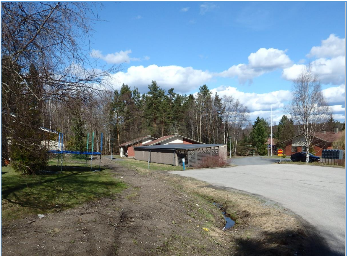
Kuva 7. Suunnittelualueen lähiympäristön rakennuskantaa.
