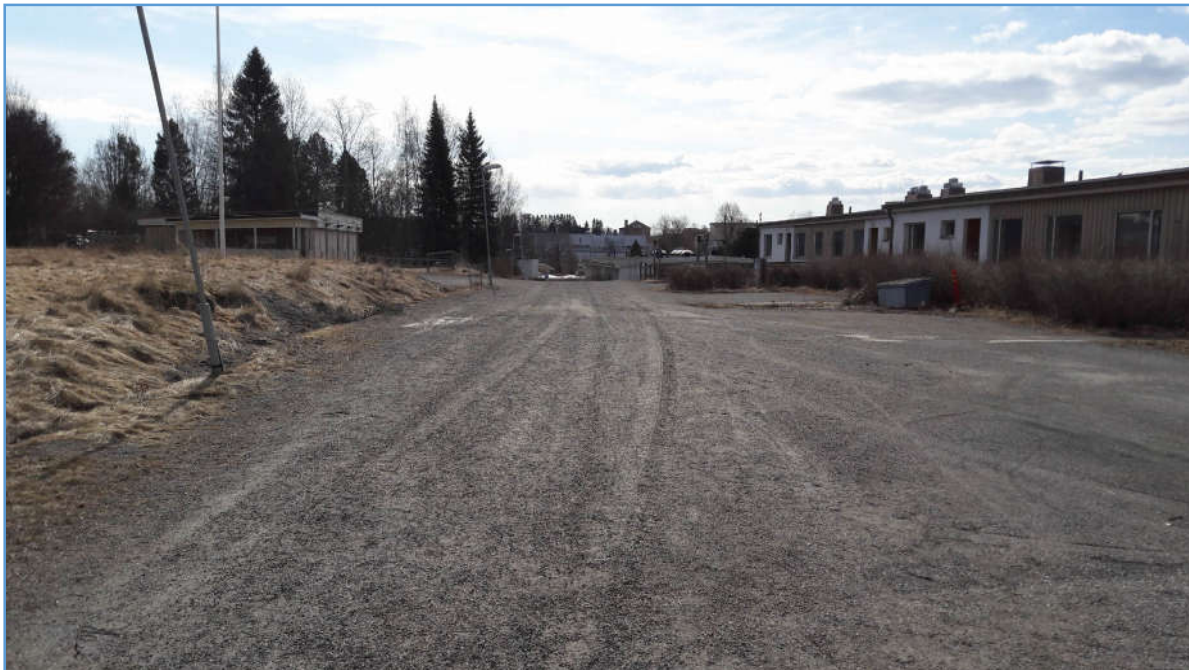
Kuva 4. Kuva korttelin sisältä kevyen liikenteen väylän suunnasta. Vasemmalla on nähtävissä vanha autotallirakennus ja oikealla olemassa olevat rivitalot.
