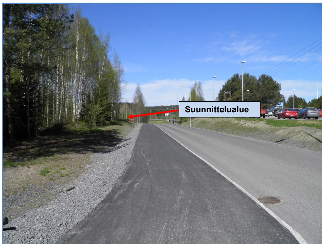
Kuva 2. Kuva otettu Patalahdenkadun ja Valionkadun risteyksestä, suunnittelualue jää vasemmalle.
