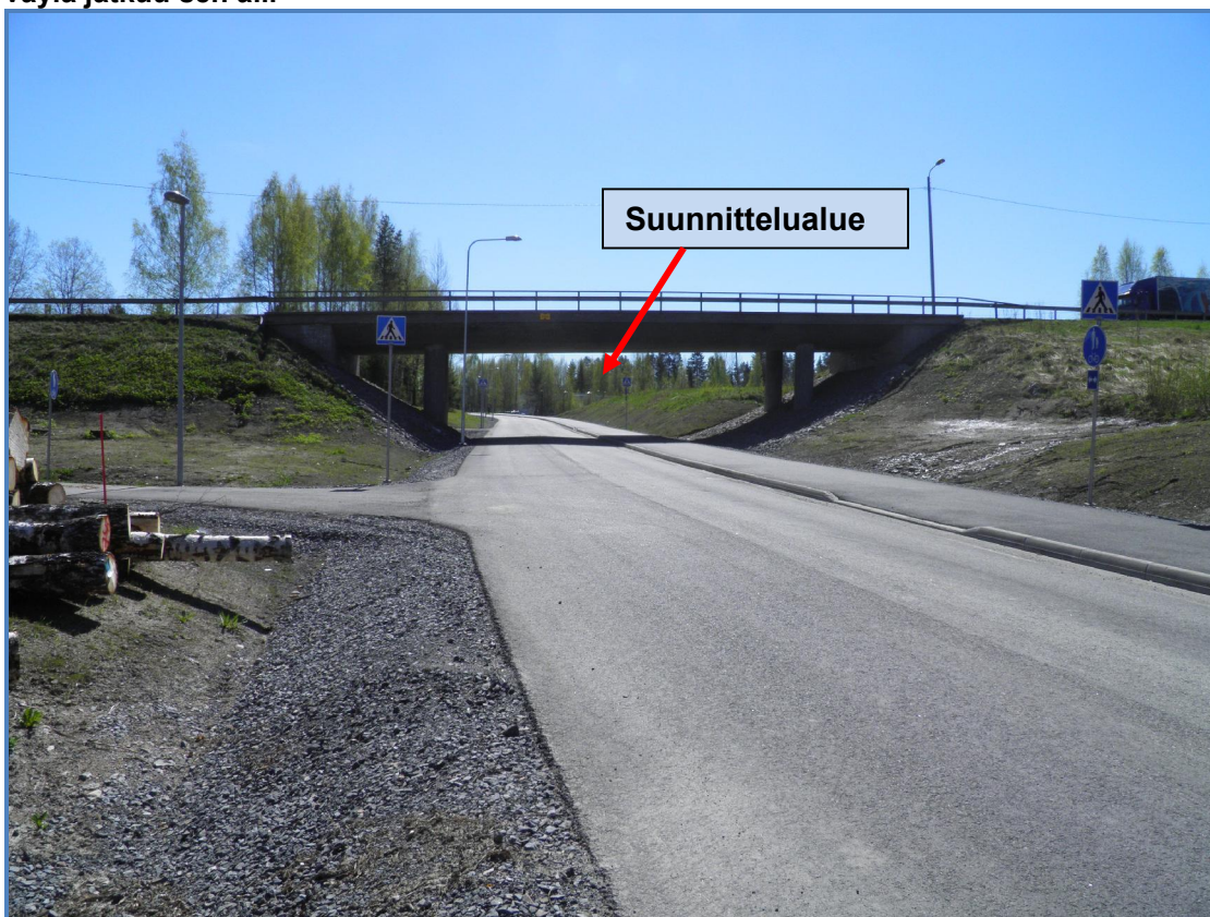
Kuva 4. Kuva otettu Valionkadun varrelta pohjoissuunnasta. Kuvassa näkyy miten kevyen liikenteen väylä jatkuu valtatie 9:n alta.
