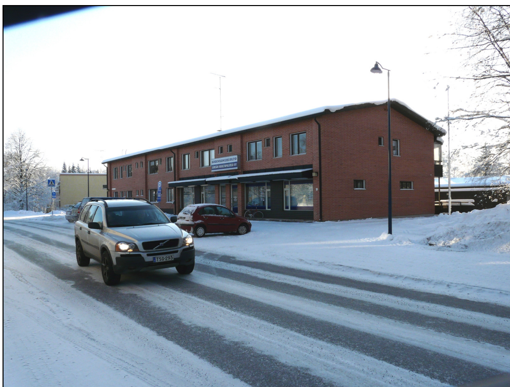
Kuva 4. Suunnittelualueen kaakkoispuolella sijaitseva kerrostalo.
