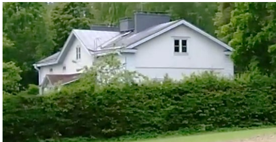
Kuva 24: Rakennus suunnittelualueen eteläpuolella.
