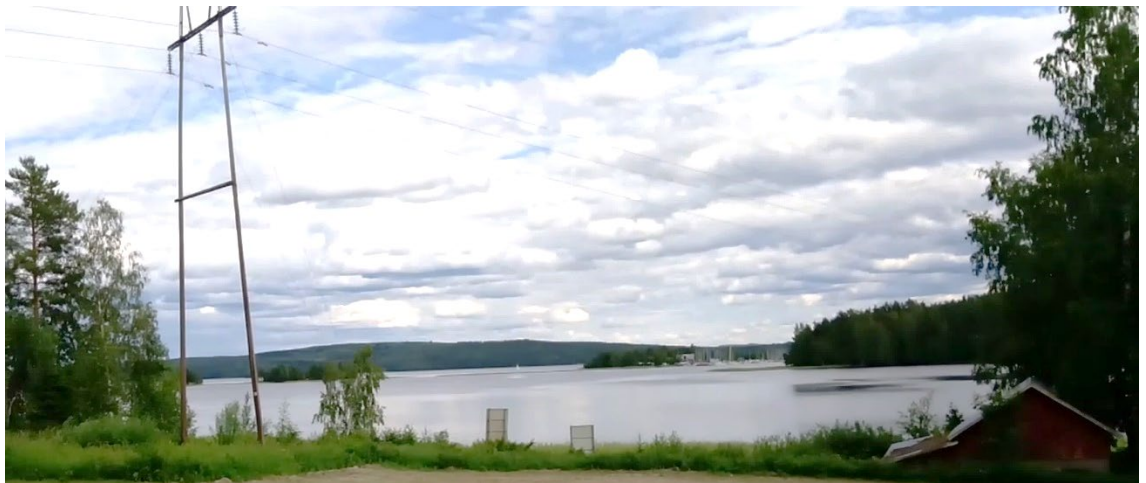
Kuva 5: Eteläosan ylittää 110 kV:n sähkölinja.
