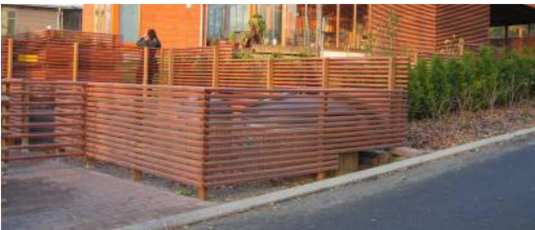
Kuva 30: Aidattu syväkeräysjäteastiasto katutilassa
