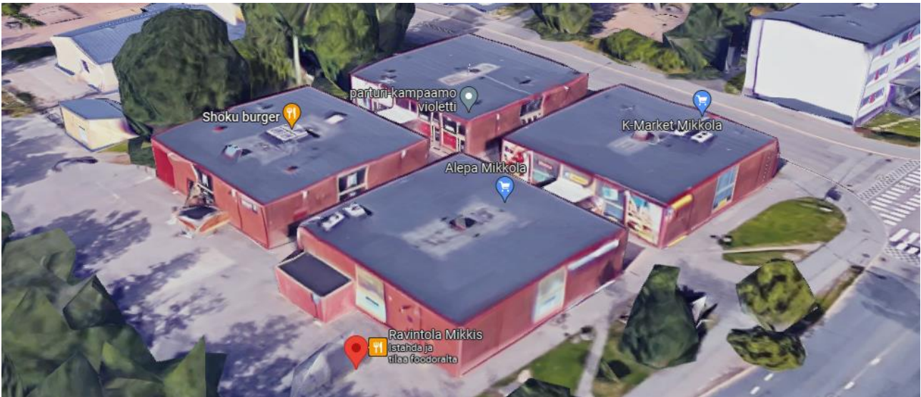
Kuva 24: Vantaalla 1960- ja 1970-luvuilla rakennetussa Mikkolan kaupunginosassa tienoota palveleva seurakuntakoti on esimerkki ympäröivään rakennuskantaan sulautuvasta kohteesta. Rakennuksen yhtenäisyys korostaa seurakuntakodin ja viereisen kirjaston, kaupan ja kuppilan samanarvoisuutta – maallisen ja hengellisen elämänpiirin lomittuneisuutta.
