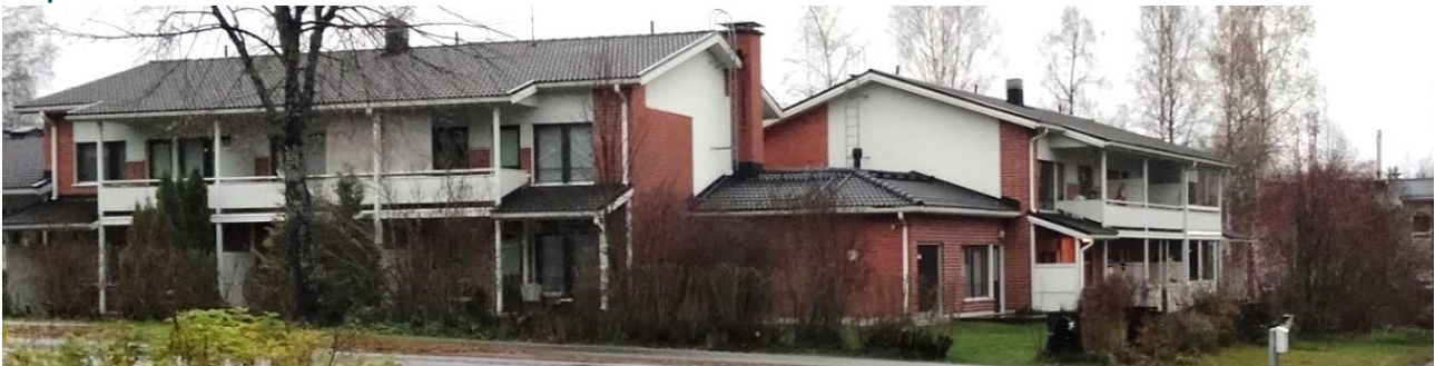
Kuva 7: Jaakkolantien vastakkaisella puolella oleva uudehko kaksikerroksinen, punatiili-valkopintainen kaksikerroksinen rivitalo.
