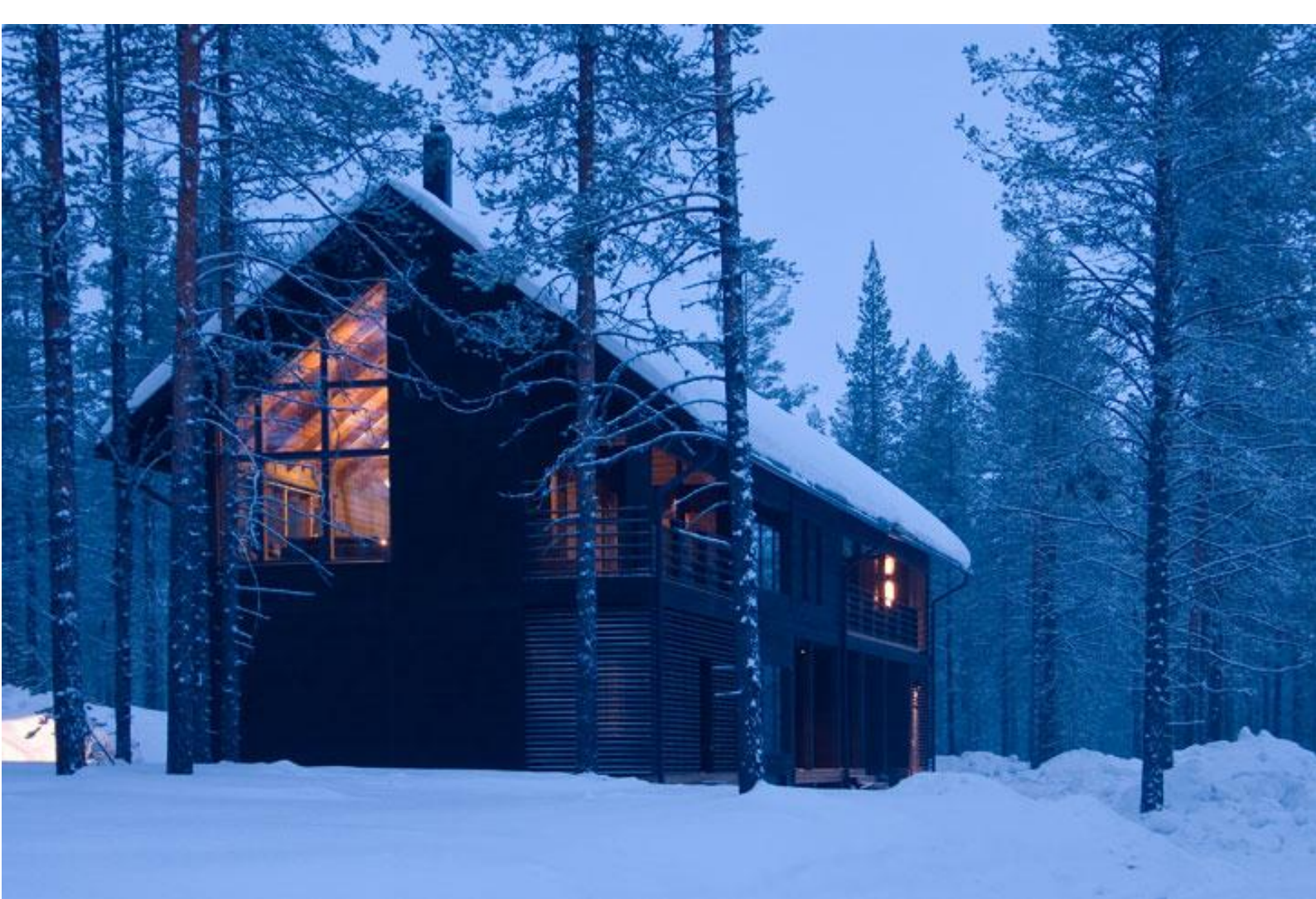
Kuva: Esimerkki tummanruskeasta tai mustasta rakennuksesta Kittilän Leviltä. Kerrosluku rakennuksessa on II.
