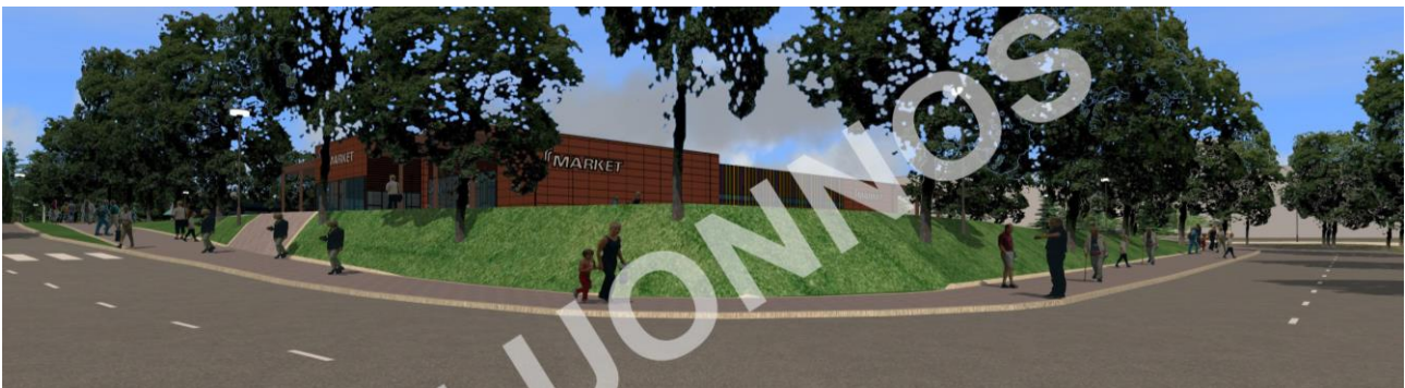
Kuva 40: Paikoitusalueen korkeusero Mikkolantien-Virastotien risteyksessä
