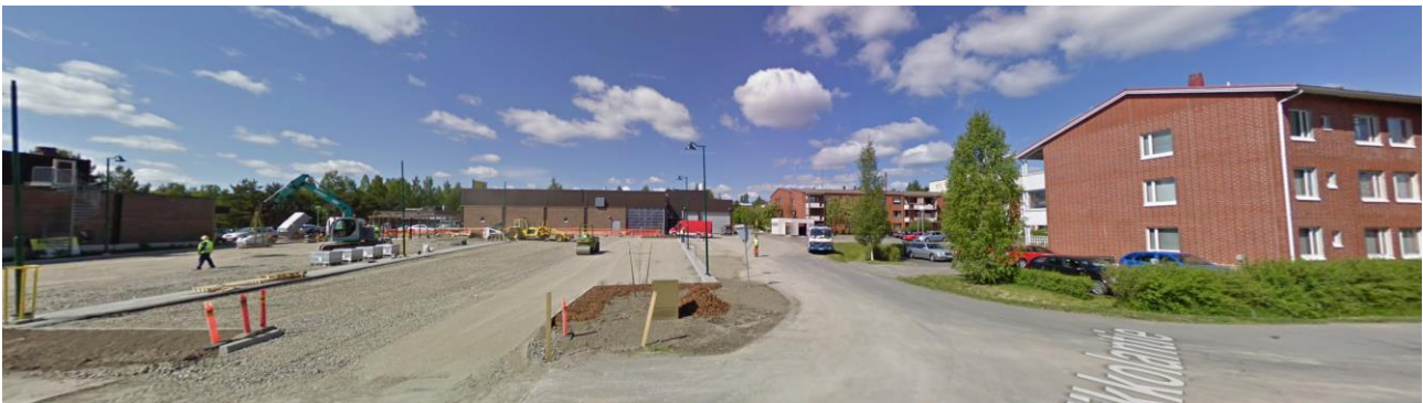
Kuva 15: Näkymä v. 2009 Manninkujalle Mikkolantieltä idästä. Olevan liikekeskuksen huoltopiha näkyy rakennusvaiheessa olevan paikoitusalueen taustalla (©Google)
