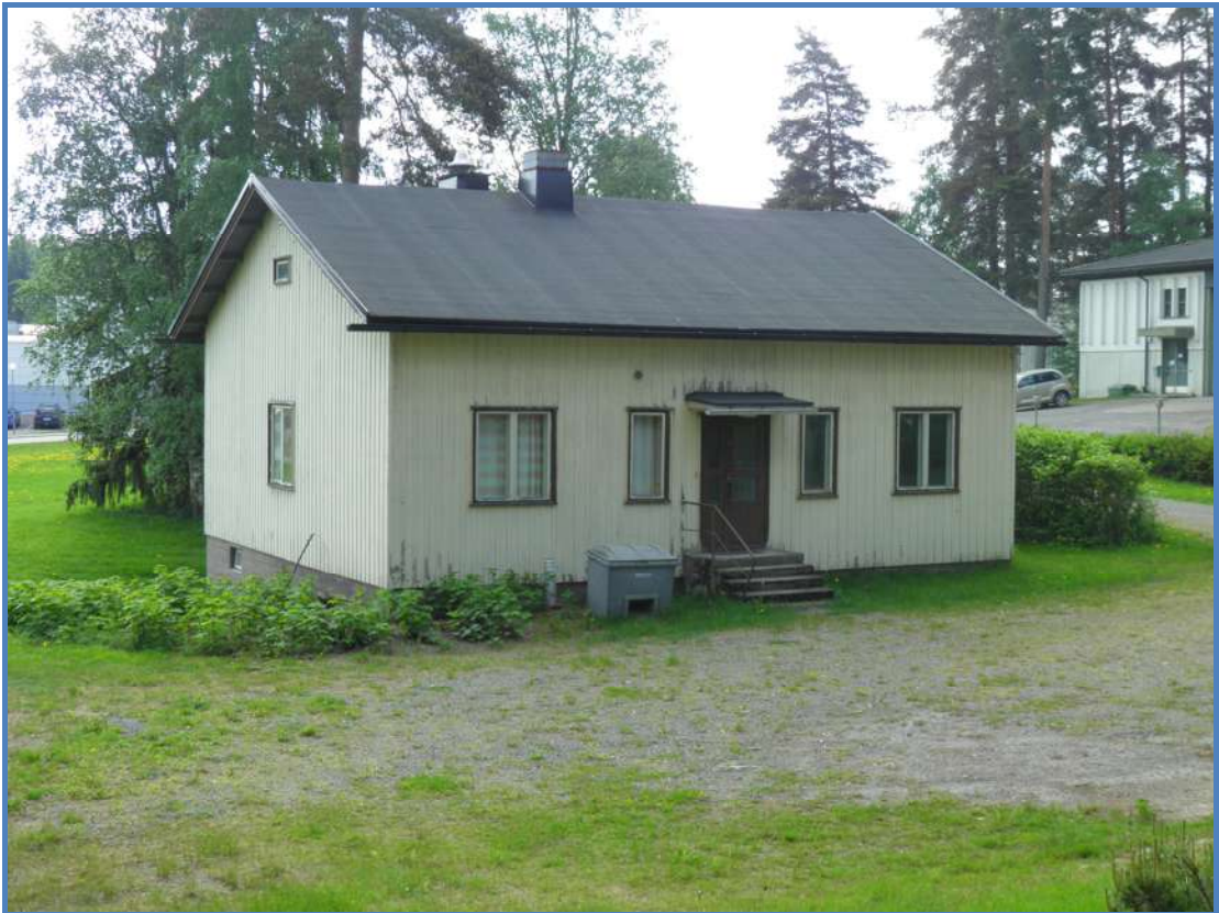
Kuva 5. Kuva alueen eteläreunassa sijaitsevasta v. 1951 valmistuneesta rakennuksesta.
