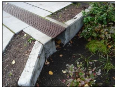
Kuva 61 Esimerkki hulevesien johtamisesta pintaan asennettavalla kourulla
