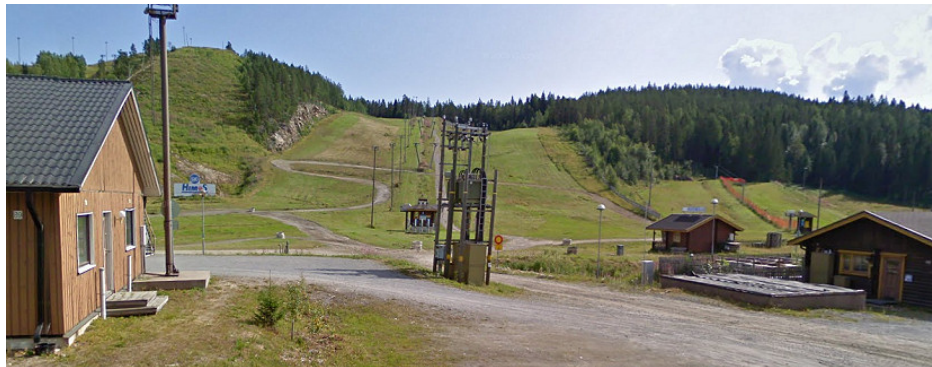
Kuva: Oleva pylväsmuuntaja Länsikeskuksessa
